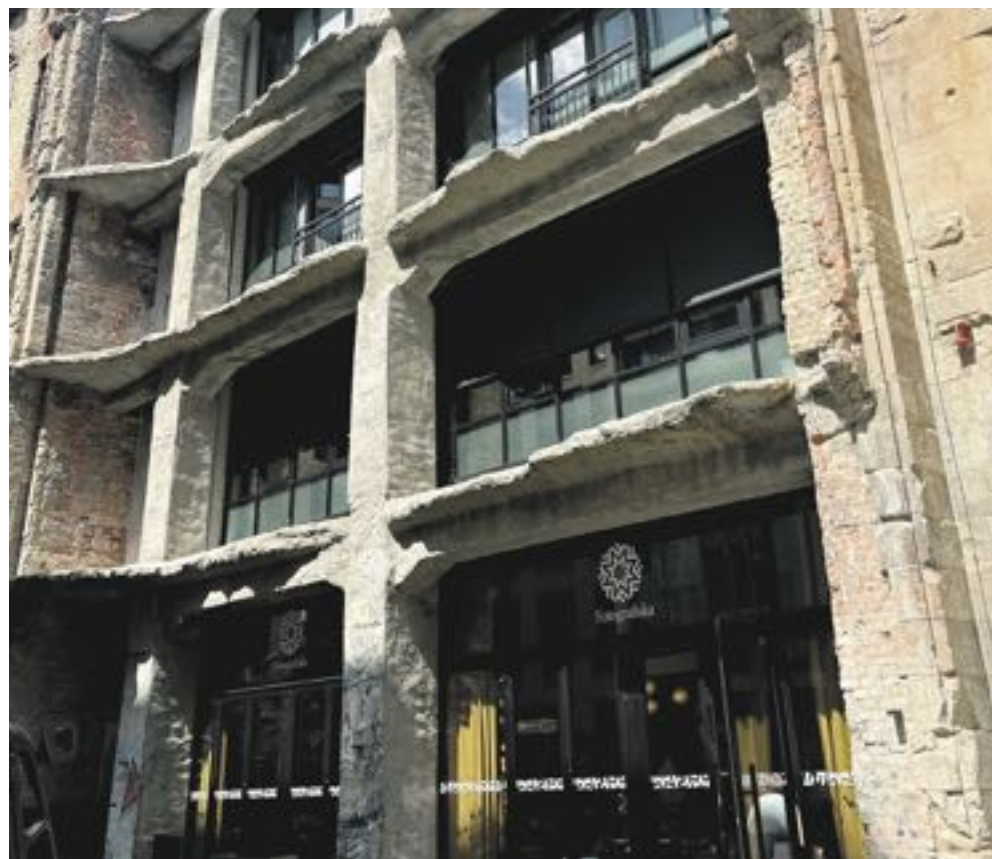
Le Fotografiska de Berlin s’est installé dans une ancienne fabrique de bière.
